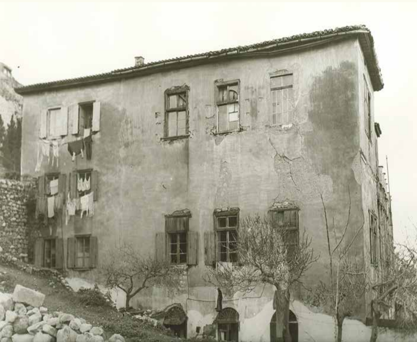
Εικ. 1: Φωτογραφία του κτηρίου (δεκαετία '60, το φωτογραφικό αρχείο του ΜΙΠΑ)
